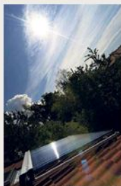
SOLFANGERE: Monteres i rammer oppå eksisterende tak.
