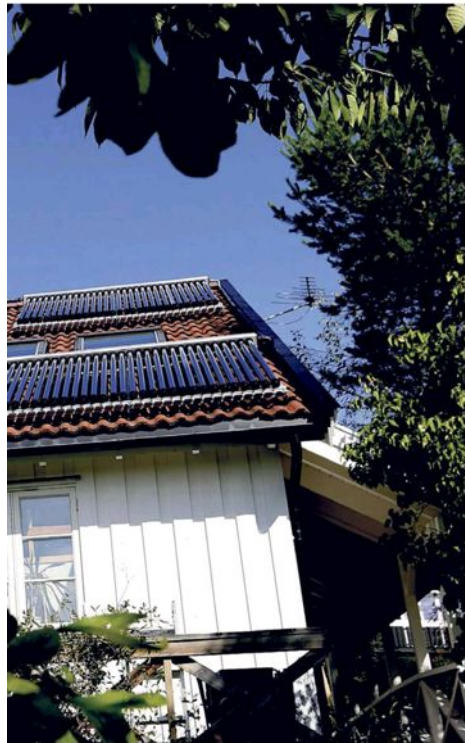
SOLFANGERE: Monteres i rammer oppå eksisterende tak.
