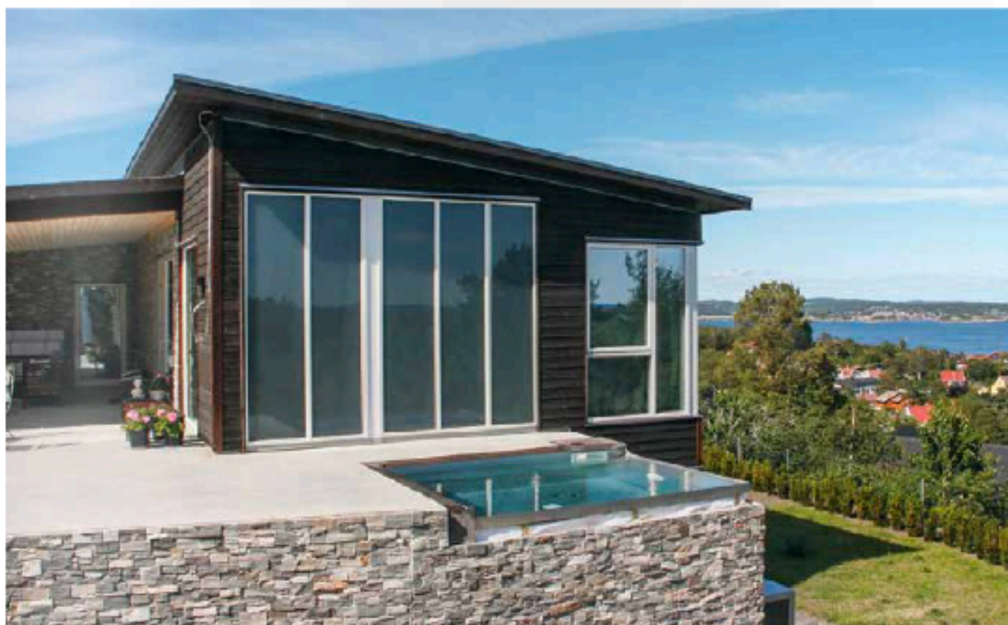
NorDan og Aventa Solar-anlegg viser frem sitt solfangerprosjekt i dette huset i Stavern
