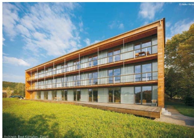
Marché International building, Zürich. PCM vinduer i kombinasjon med konvensjonelle vinduer (Foto: GlassX Inc., Sveits)
