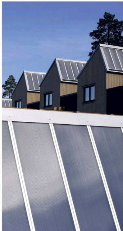
VARME: I disse OBOS-husene blir solfangerne hovedoppvarmingskilden, og dekker 60 prosent av energibruken.
