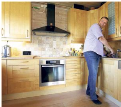
VARMT VANN: Solfangere brukes til å varme opp vann. Håkon Borch kaller det spekefullt for gratis varmtvann.
