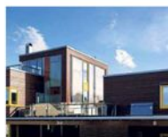
I VEGGEN: Dette huset har solfangere integrert i ytterveggen (midt i bildet).
