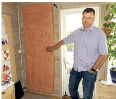
RADIATOR: Platen på veggen ser ut som et kunstverk, men er i virkeligheten en radiator knyttet til Håkon Borchs solfangeranlegg.
