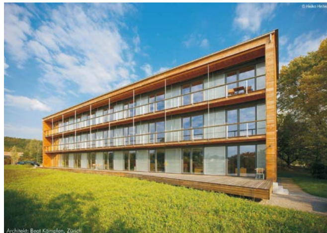
Marché International building, Zürich. PCM vinduer i kombinasjon med konvensjonelle vinduer (Foto: GlassX Inc., Sveits)
